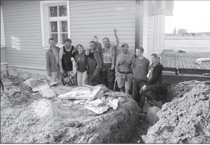
Lastekaitsepäeval tuli talgulistel tegelda seltsimaja vundamendi lahtikaevamise ja soojustuse parandamisega
