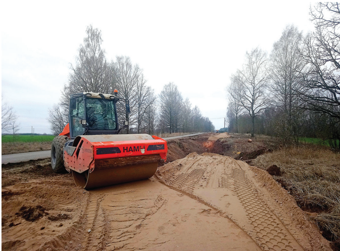
Jaanuarikuu alguses toimusid aktiivsed tee-ehitustööd Nõo–Voika lõigul. Foto: SVEN TARTO
